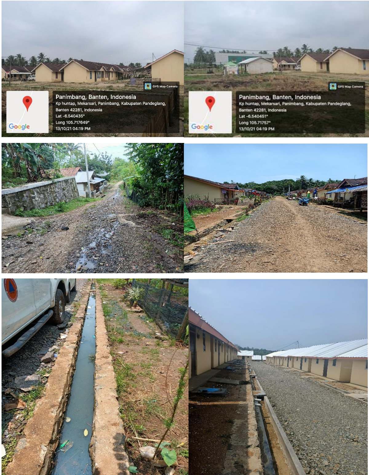
Kondisi Perumahan dan Infrastruktur Huntap
