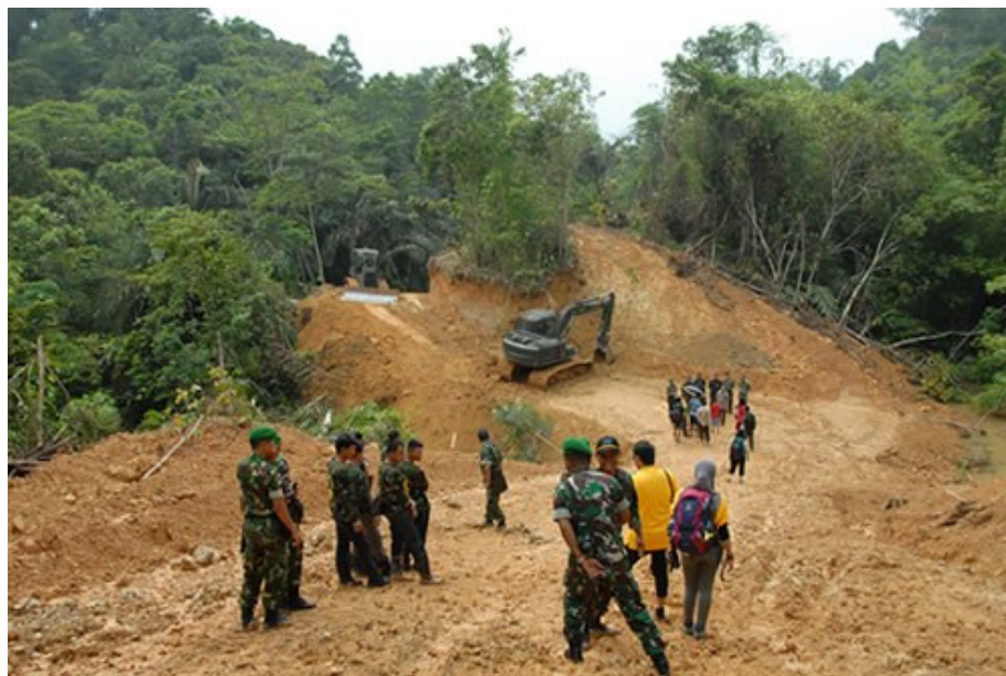
Gambar 4.19 Kemhan Melaksanakan Pembangunan JIPP Kalbar
