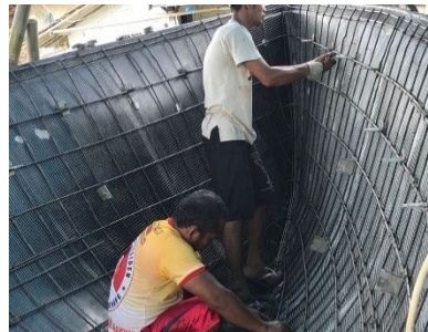
Gambar 4.6 Ilustrasi Proses Pemasangan Reinforcement
