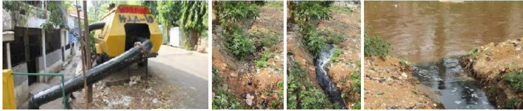
Gambar 4.26. Saluran Drainase Yang Menggunakan Bantuan Pompa. Sumber: Hasil survei.
