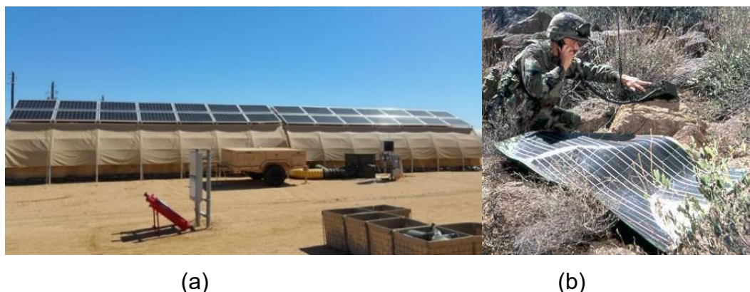
Gambar 1.2 (a) Tenda dengan Panel Surya, (b) Penerapan Teknologi Sel Surya dalam Operasi Militer
