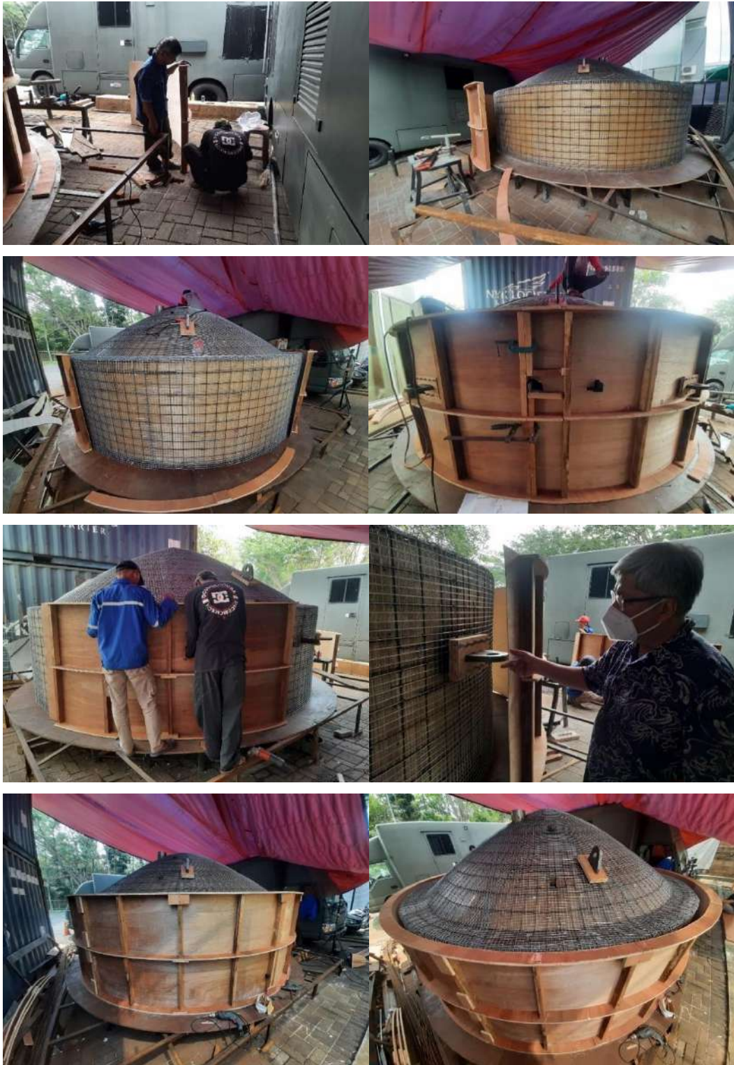
Gambar 6.12 Proses pembuatan bekisting untuk dinding hull FECABS
