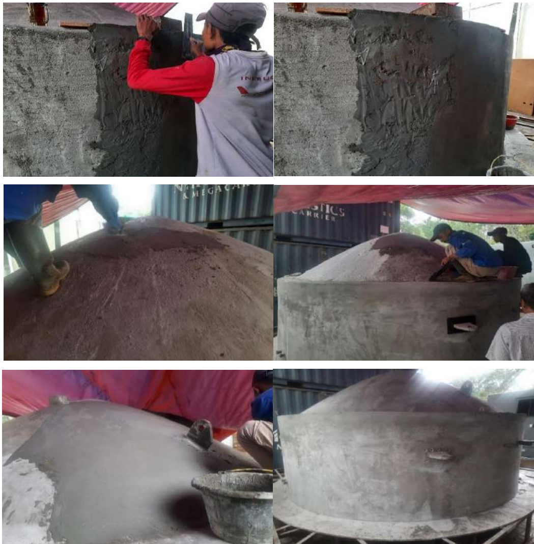
Gambar 6.20 Proses pelapisan kedap air pada FECABS
