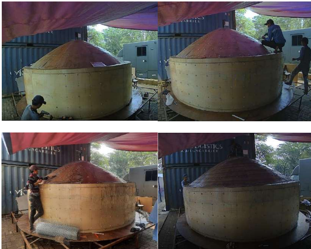
Gambar 6.9 Proses pemasangan spacer ceramic dan wire mesh pada FECABS
