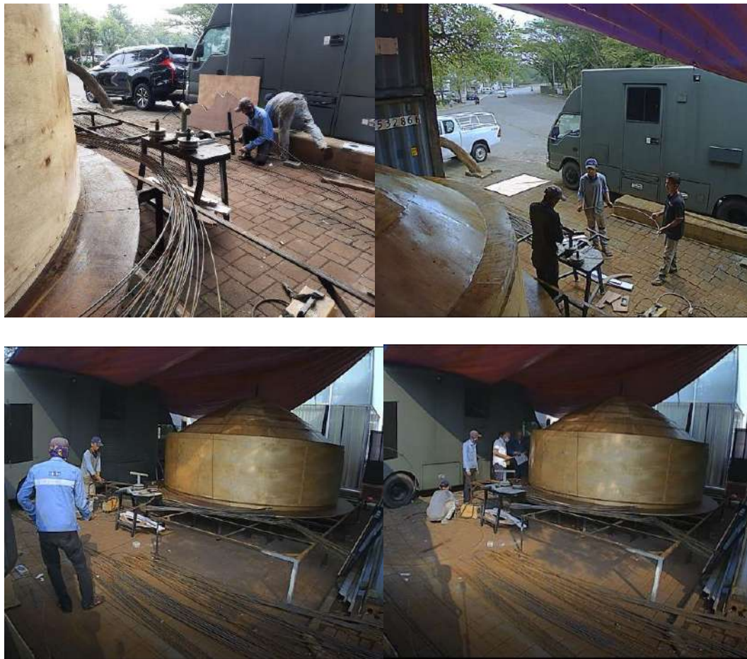
Gambar 6.8 Proses pembuatan reinforcement FECABS
