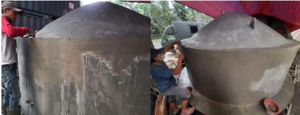
Gambar 6.19 Proses penghalusan pada seluruh dinding FECABS
