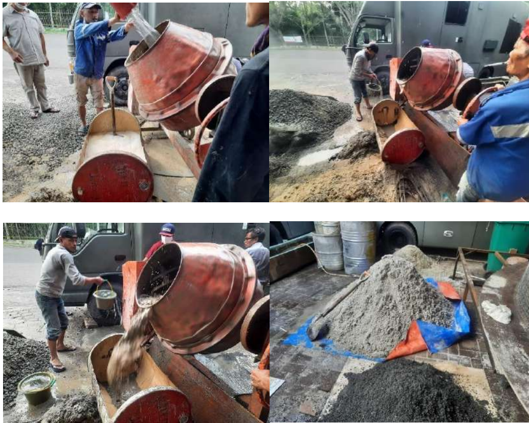
Gambar 6.14 Proses pencucian pasir Jalupang dengan molen yang digunakan sebagai bahan ferrocement
