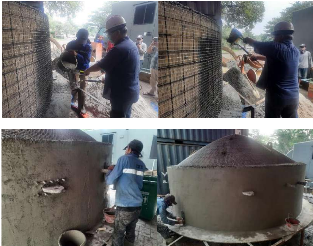
Gambar 6.17 Proses pengecoran pada dinding FECABS
