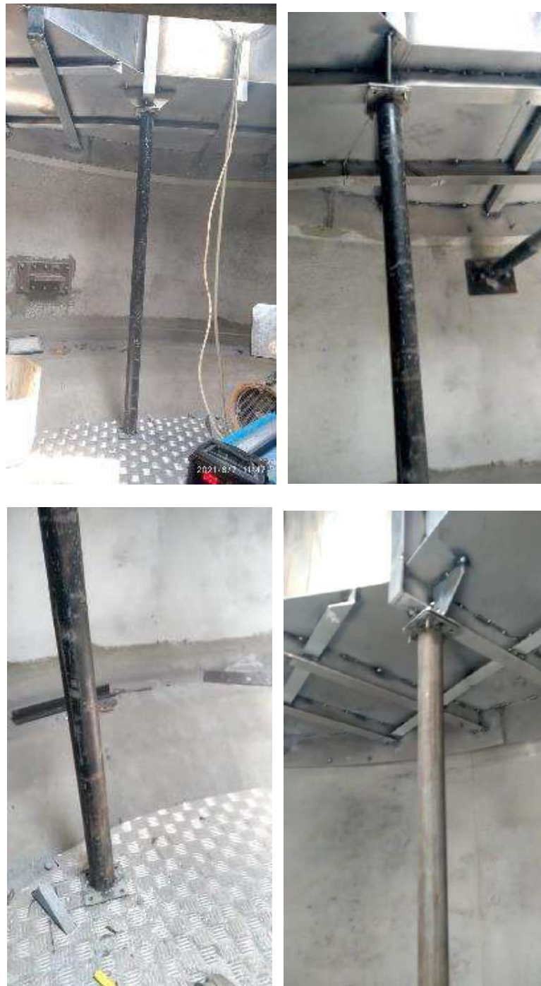
Gambar 6.38 Pembuatan Tiang dalam FECABS
