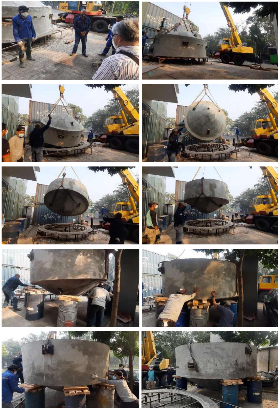
Gambar 6.32 Proses Pembalikan Hull FECABS
