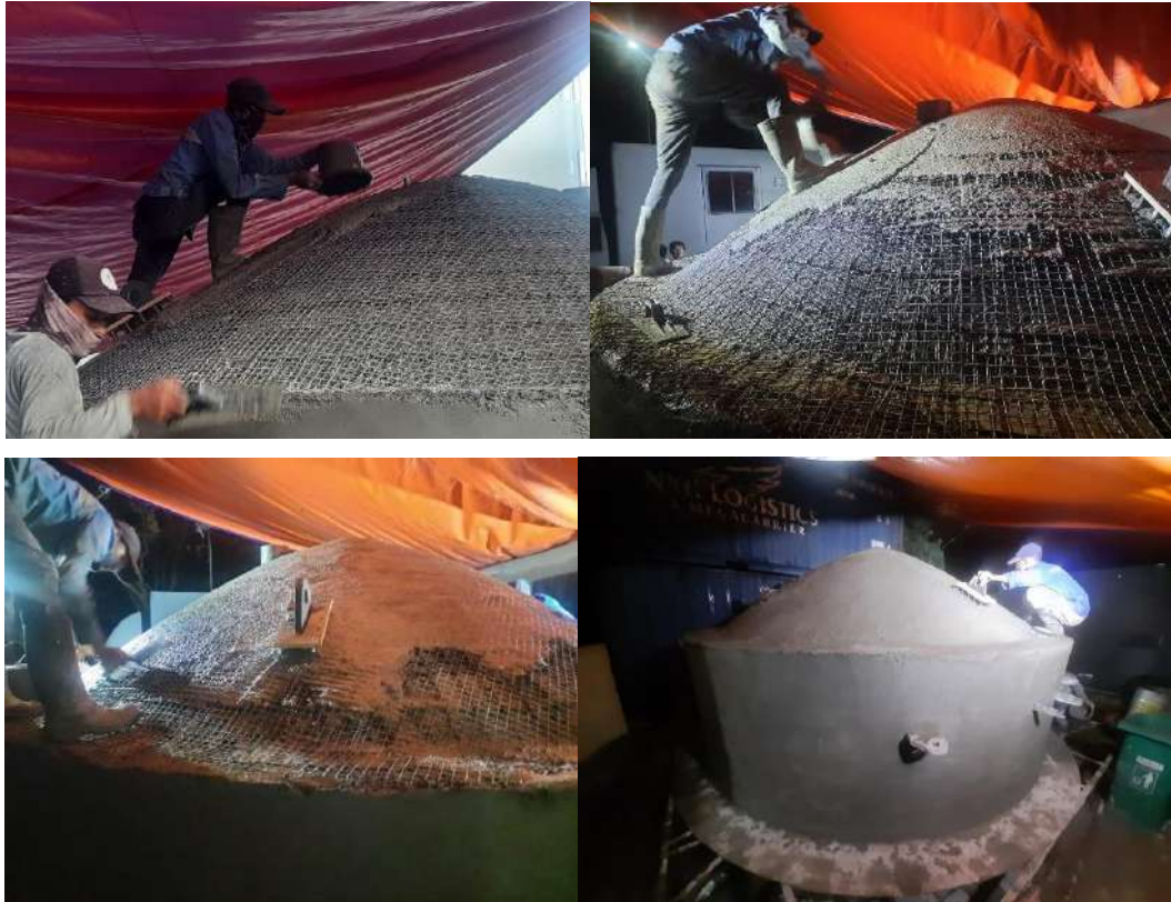
Gambar 6.18 Proses pengecoran pada bottom FECABS
