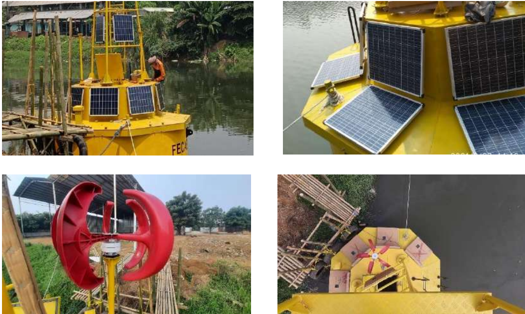
Gambar 6.36 Proses pemasangan sumber tenaga FECABS
