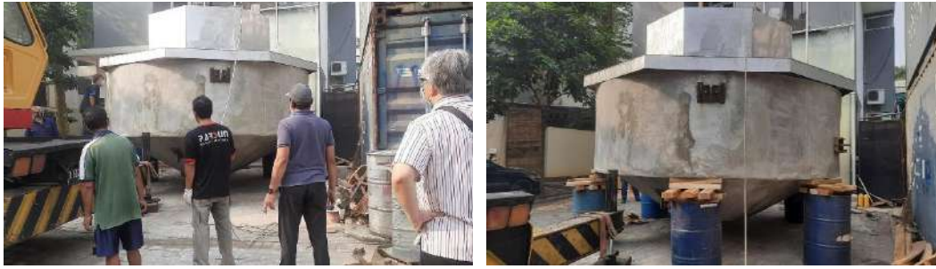
Gambar 6.34 Proses Penggabungan Hull dan Suprastruktur FECABS
