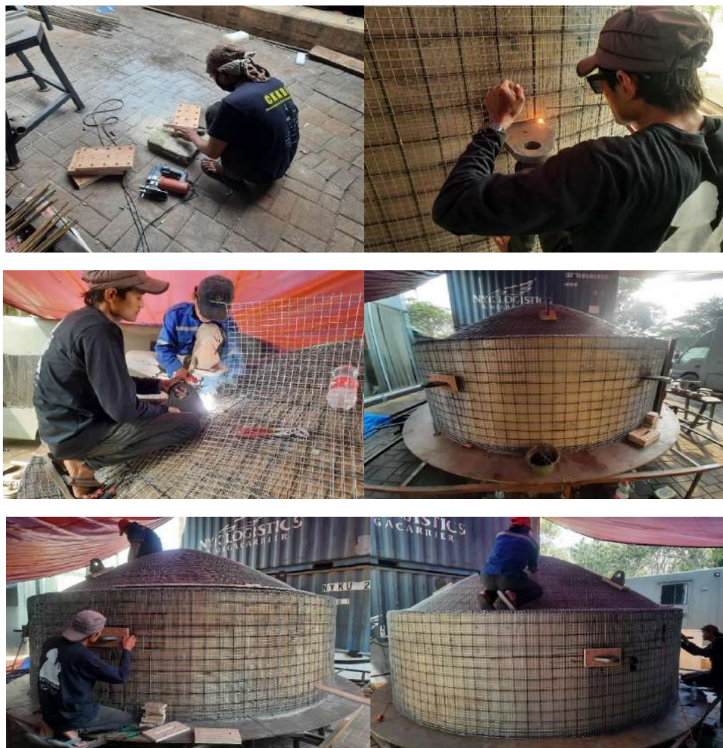
Gambar 6.11 Proses penempatan bracket pada FECABS
