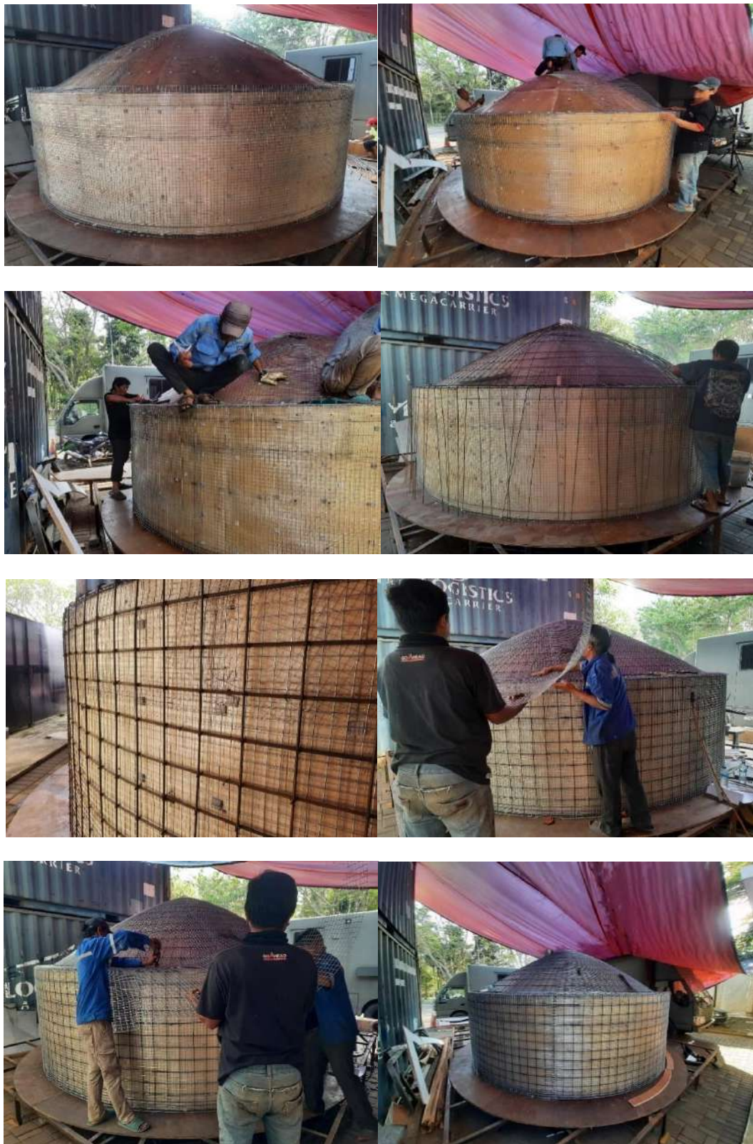
Gambar 6.10 Proses pemasangan komposisi lapisan dinding FECABS
