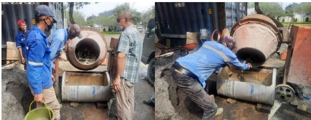
Gambar 6.16 Proses pencampuran adukan Ferrocement menggunakan molen
