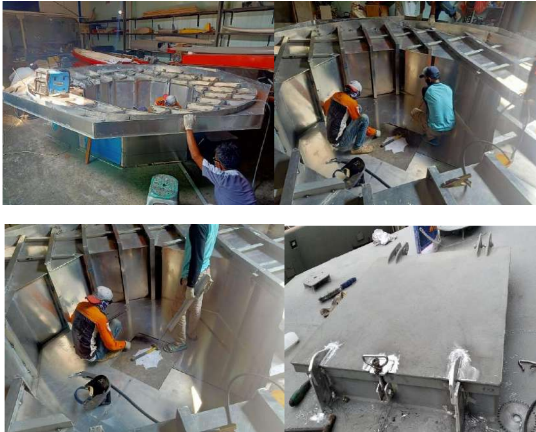
Gambar 6.27 Proses pembuatan manhole FECABS
