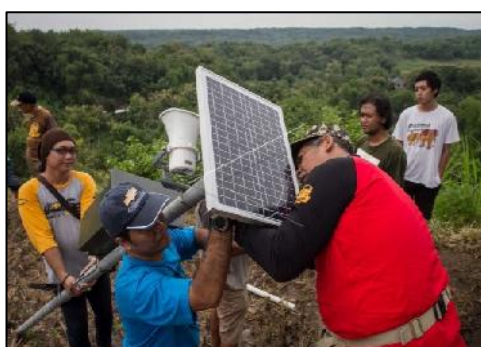
Gambar 4.47a Pemasangan Alat Peringatan Dini Tanah Longsor Sumber: Antarafoto (2019)
