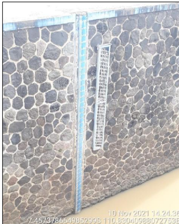
Gambar 4.29 Alat Pengukur Tinggi Muka Air Bendung Bapang
