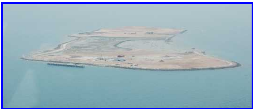
Gambar 1.3 Pulau Nipa setelah direklamasi
