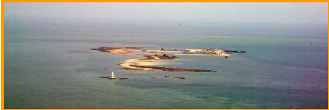
Gambar 1.2 Pulau Nipa sebelum direklamasi
