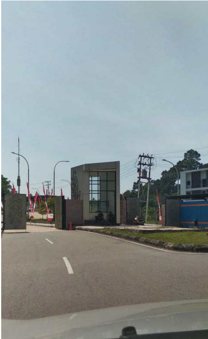
Mendekati ke arah pintu gerbang PLBN Aruk
