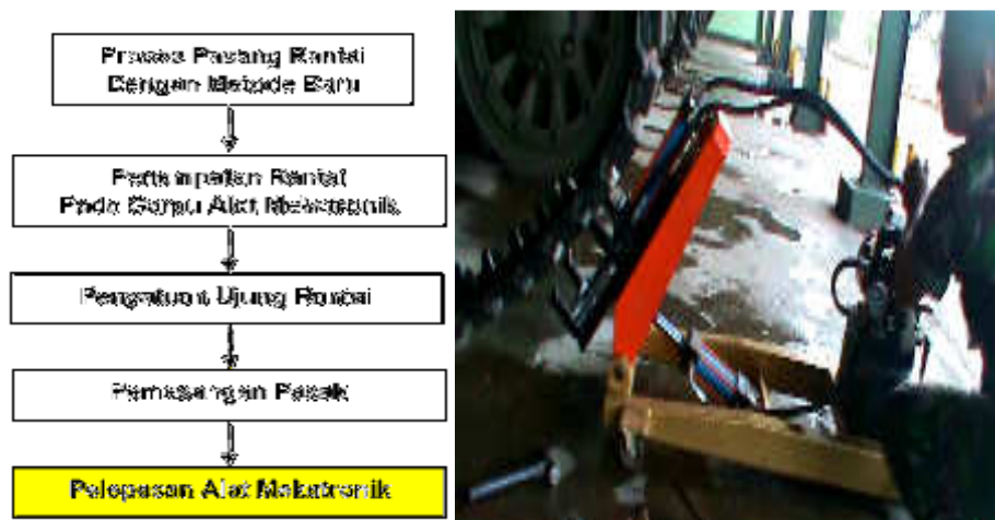
Gambar 4.23 Pelepasan Alat Mekatronik Dongpit dari Roda Rantai
