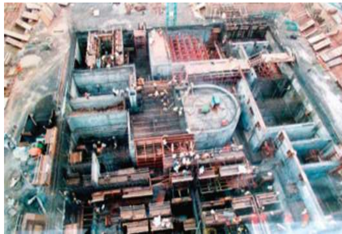
Gambar 4.24 Pembangunan RSG-GAS Pada Tahun 1983
