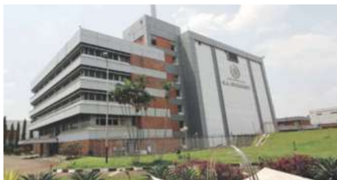
Gambar 4.20 Bangunan DPFK Pengelola RSG-GAS
