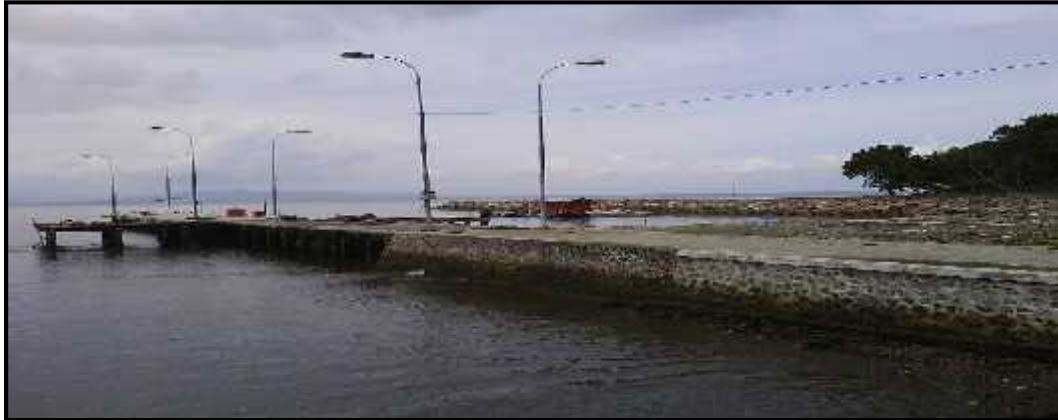
Gambar 27: Dermaga TPI Jaboi (Sumber : dokumentasi langsung 20 Mei 2013)
