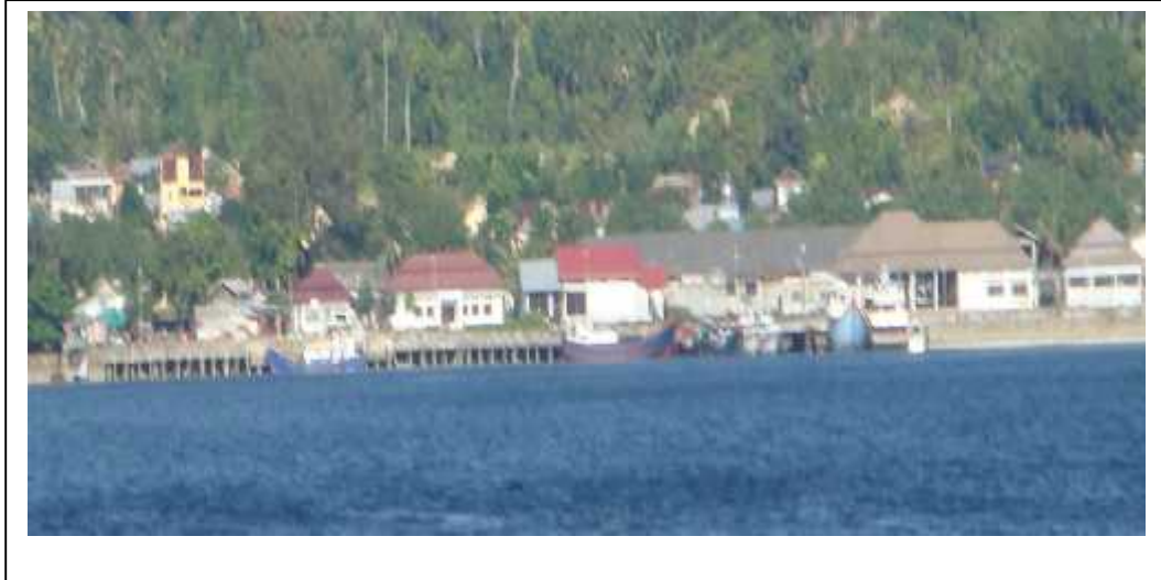
Gambar 21: Dermaga PSB Pasiran Sabang (Sumber : dokumentasi langsung 11 Mei 2013)
