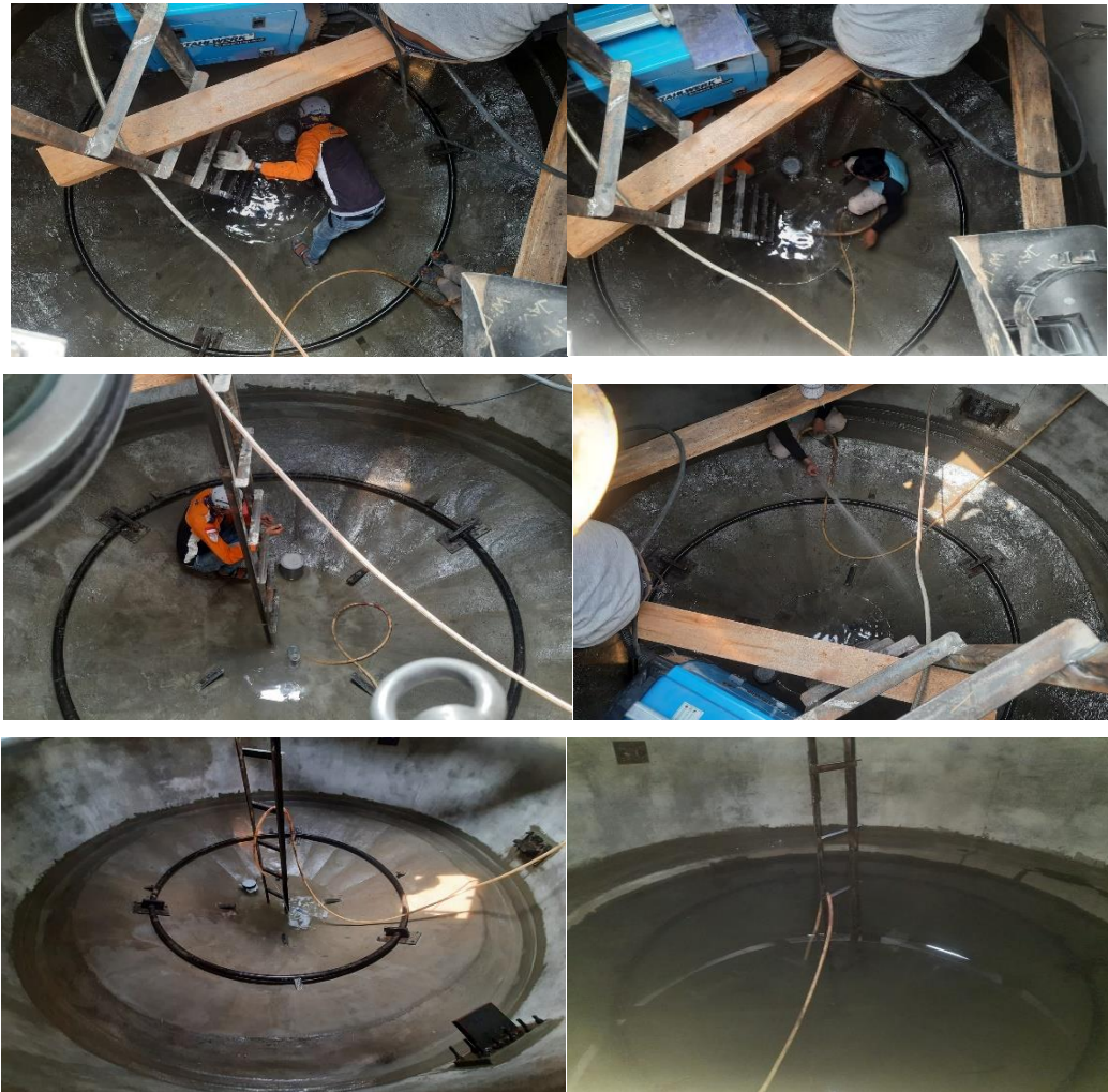
Gambar 7.7 Proses pengujian kebocoran air pada FECABS
