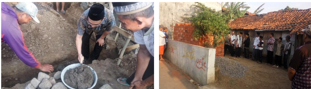
Gambar 4.17. Kegiatan Habitiasi Gotong Royong Pembangunan Rumah 169
