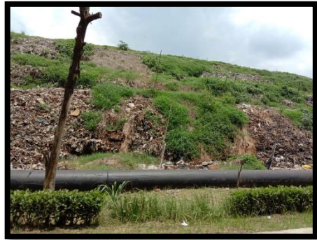
Kondisi Zona I dan II TPST Bantargebang (Zona tidak aktif) terpasang pipa gas
