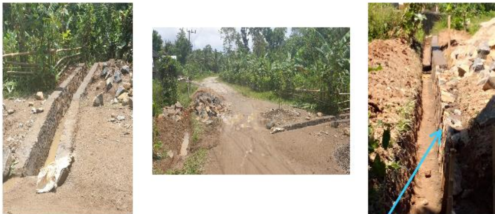
Gambar 4.3 Pembangunan Saluran Gorong-Gorong di Huntap Desa Ujungjaya
