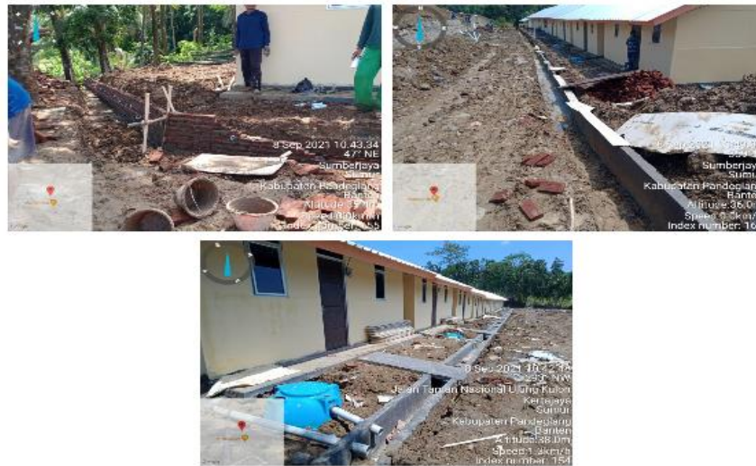
Gambar 4.4 Pembangunan Saluran Drainase di Huntap Desa Sumberjaya
