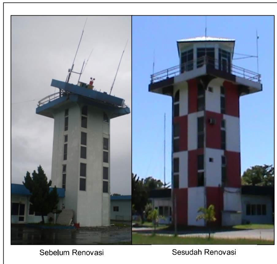
Gambar 4.28 ATC Tower Lanud Padang sebelum dan sesudah renovasi akibat gempa bumi 2009
