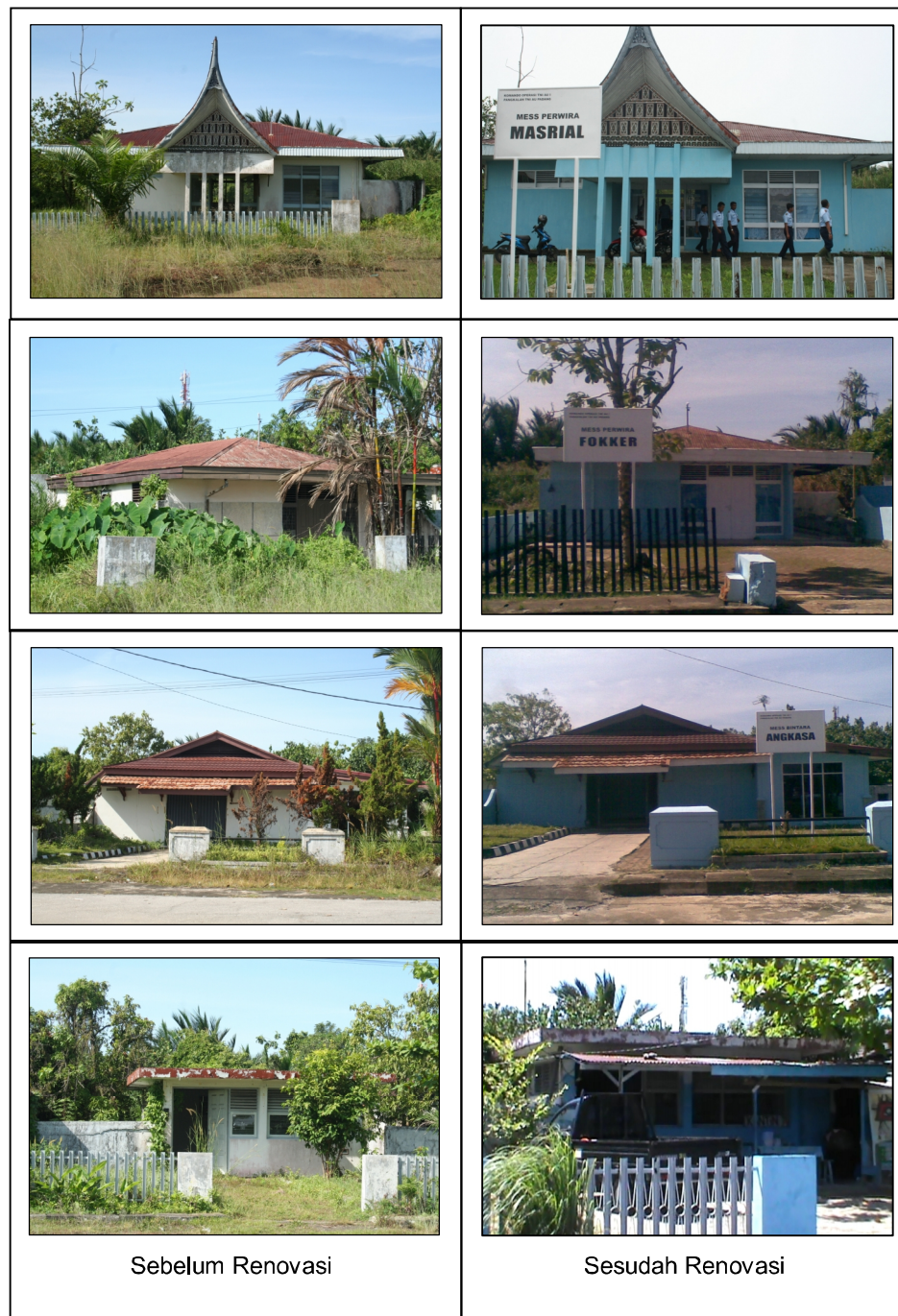
Gambar 4.29 Renovasi Mess Eks Bandara Tabing
