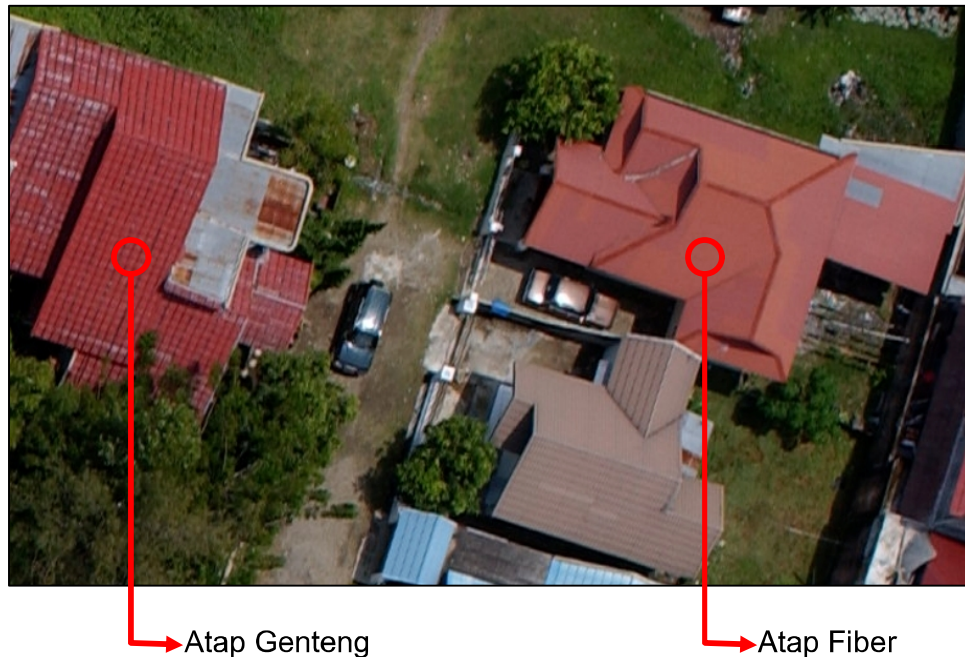
Gambar 4.9 Citra potret udara atap bangunan dengan material genteng dan fiber
