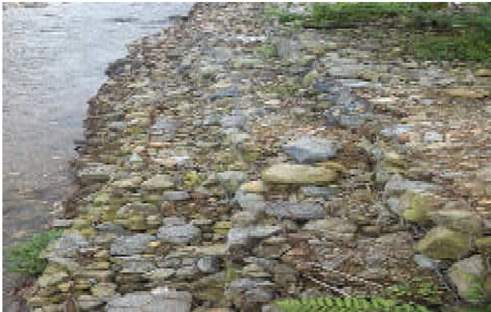
Gambar 4.6 Pembangunan Bronjong di sekitar Sungai Tundo
