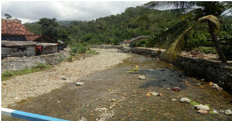
Gambar 4.7 Plengsengan atau Tembok Penahan Tanah (TPT) atau Talud yang dibangun di sekitar Sungai Tundo
