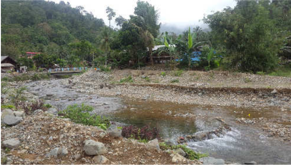
Kondisi Sungai Tundo Desa Pujiharjo yang mengalami pendangkalan
