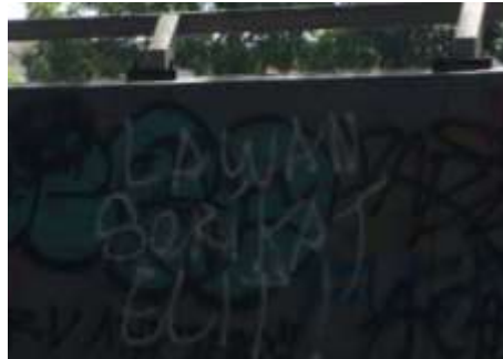
Gambar 4.8. Vandalisme “Lawan Serikat Elite” di Jembatan Pasopati.
