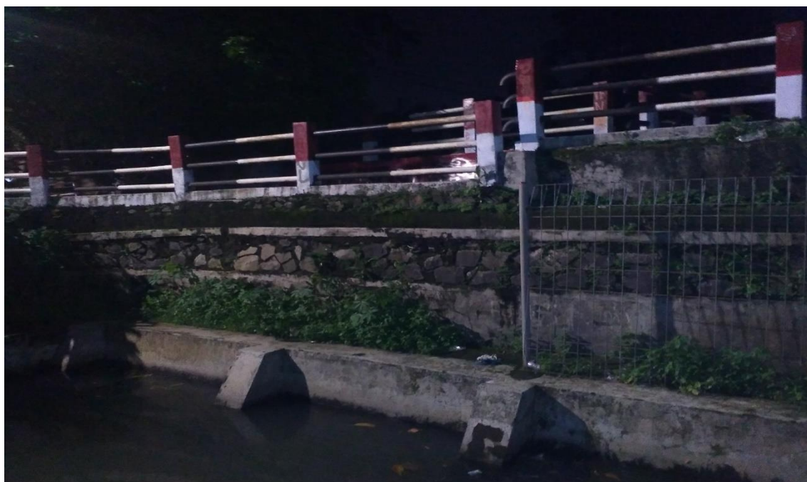
Kondisi Bak penampungan air sementara di Gedung Pompa IKPN Bintaro
